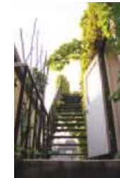
ROOFへの階段
